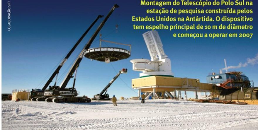
**Montagem do Telescópio do Polo Sul na estação de pesquisa construída pelos Estados Unidos na Antártida. O dispositivo tem espelho principal de 10 m de diâmetro e começou a operar em 2007**
