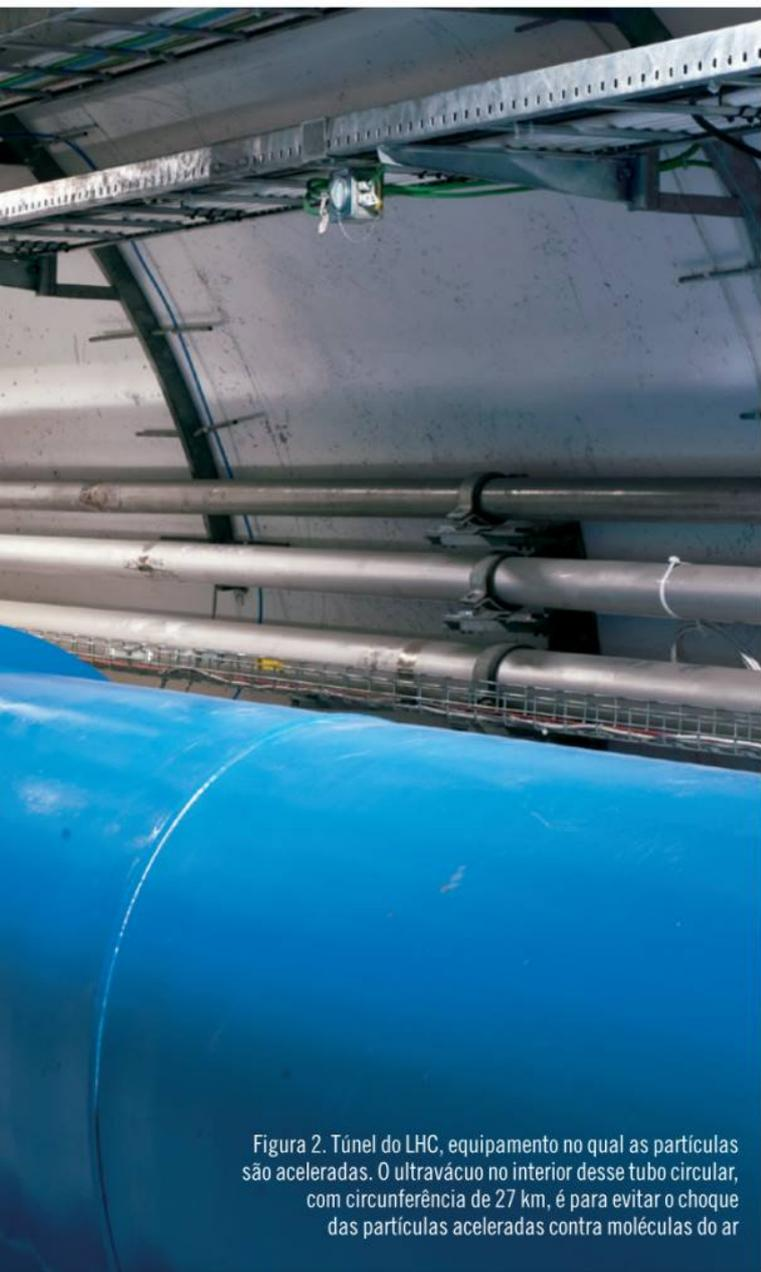
Figura 2. Túnel do LHC, equipamento no qual as partículas são aceleradas. O ultravácuo no interior desse tubo circular, com circunferência de 27 km, é para evitar o choque das partículas aceleradas contra moléculas do ar
